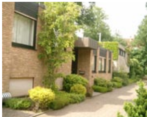
Beispiele für die Qualitäten von Flachdachsiedlungen (Diemshoff, Emsdetten)
